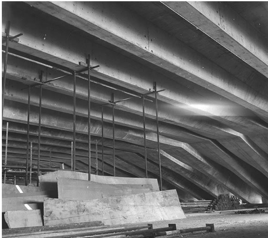
Vista de la gran escalinata desde abajo. Atención a la compleja sección y respetable tamaño de las vigas que la sostienen.
